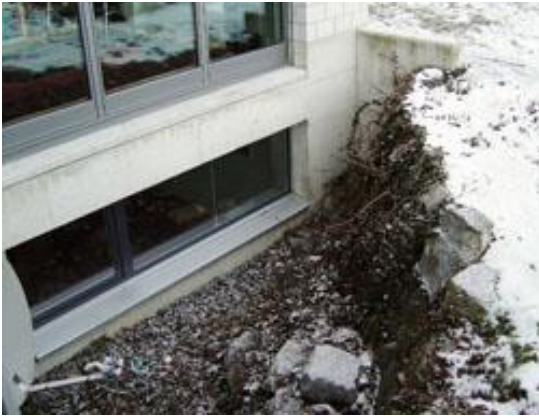
Fenster mit erhöhter Wasserdichtigkeit
